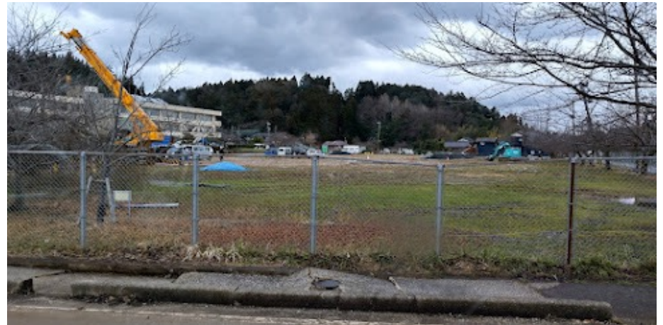
珠洲市正院小学校の校庭で仮設住宅の 建設が始まっている 1/15
